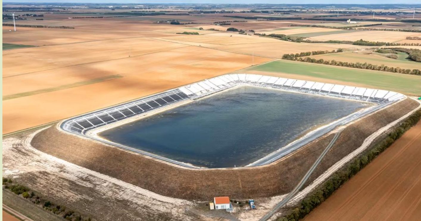
Une réserve d'eau agricole géante dans le sud Vendée sur la commune de NALLIERS, le 26/09/2022.
