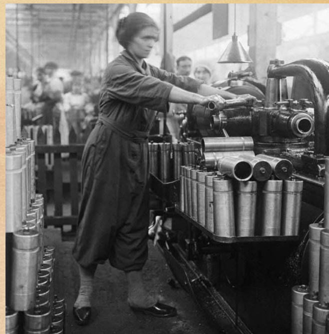
Femme tournant des douilles d'obus, Usine Citroën, Paris, 1915 - 1917.
